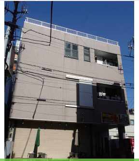
湘南平塚セントラルビル
