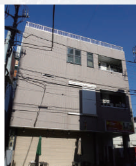
湘南平塚セントラルビル
